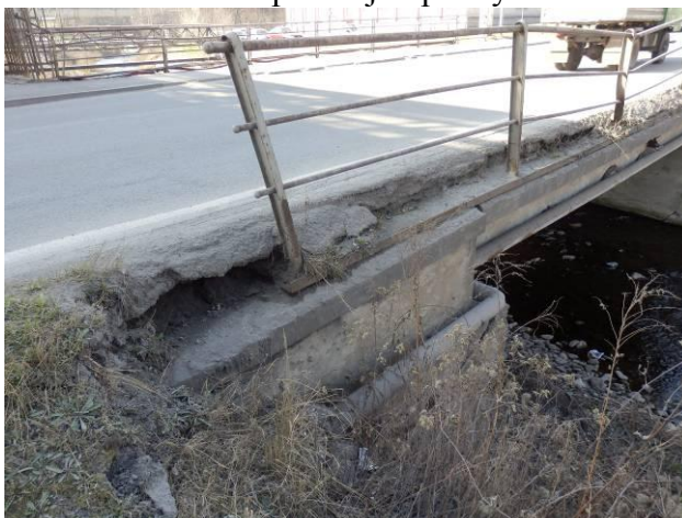
Zábradlí a římsa vpravo – římsa „utopená“ pod vozovkou, zábradlí je zdeformované, zkorodované, špatně upevněné a s nedostatečnou výškou
