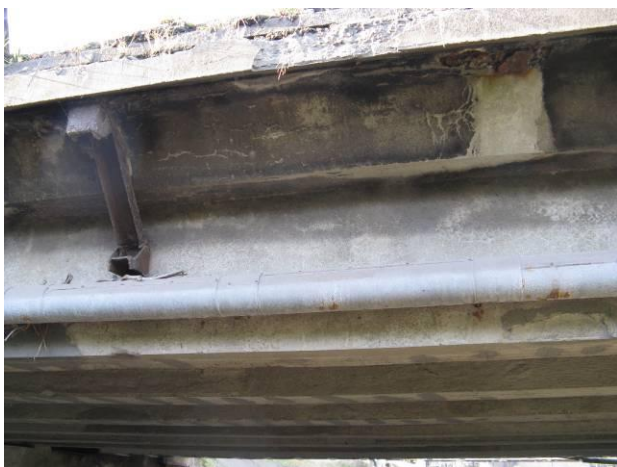
Pravý bok NK – ocelová vzpěra římsy, rozpadlá římsa cca uprostřed rozpětí
