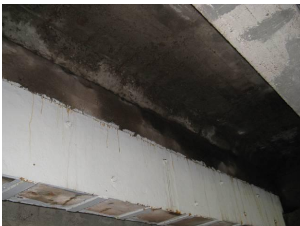
Podélná trhlina u trámu č.3 mezi vozovkovou a chodníkovou částí – zatékání skrz trhlinu
