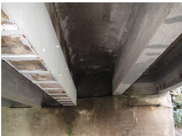
Podhled NK pod chodníkem - oplechování trámů 1 a 3 z vtokové strany, obnovený protikoroziční nátěr
