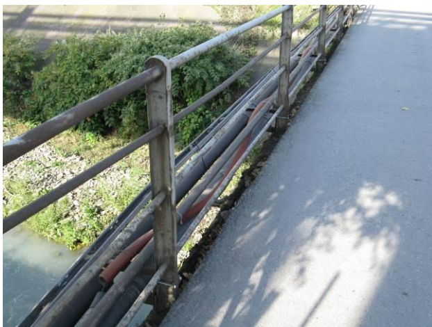
Zábradlí a římsa vlevo – římsa „utopená“ pod chodníkem, velké množství neudržovaných sítí, zábradlí neodpovídající platným ČSN
