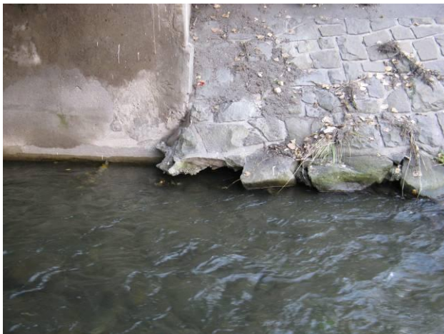
Vyplavené opevnění koryta na vtoku
