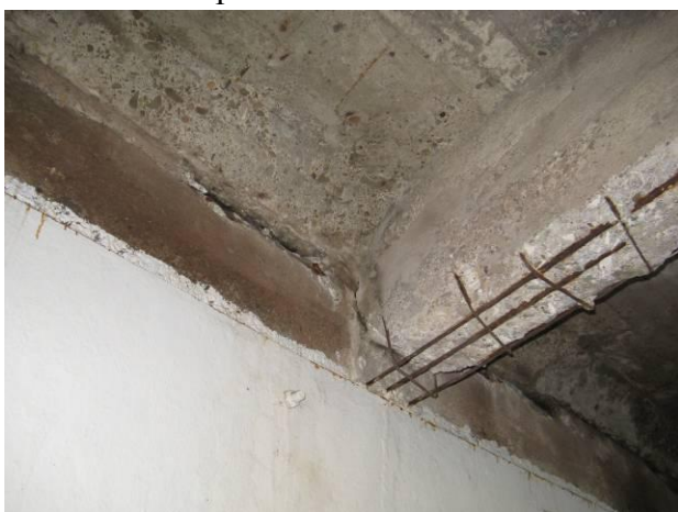
Mezilehlý příčník pod chodníkem mezi trámy č.2 a 3 - obnažená výztuž po odprsknutí betonu ze spodního líce
